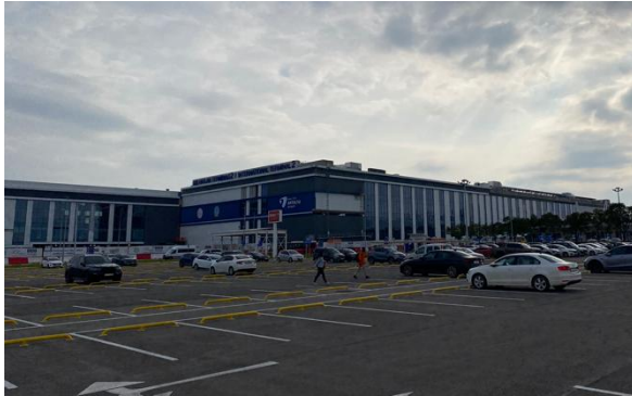
Şekil 4 Genişleme Çalışmalarından Sonra Yeni Terminal 2
